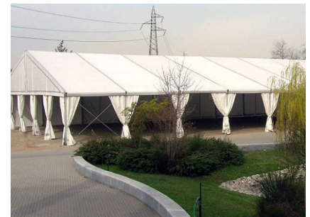
Esempio di allestimento
